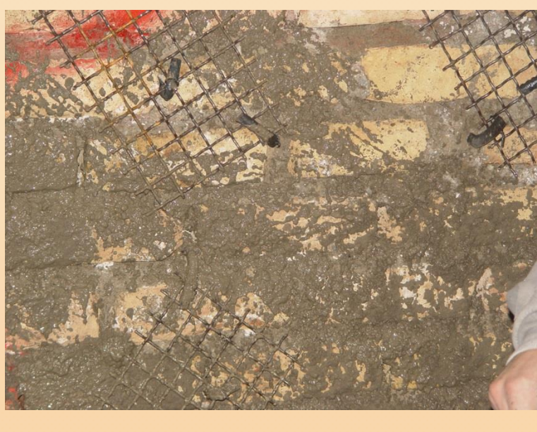
نحوه اجرای لایه اول سیمانکاری
